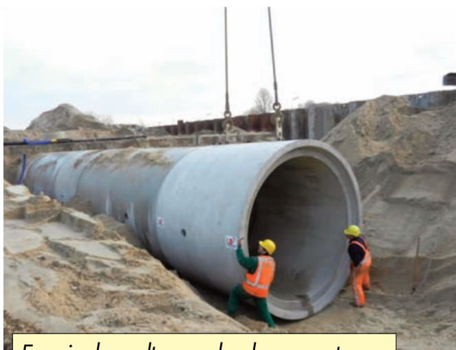
Een riool wordt aangelegd: een grote buis onder de grond waar het vieze water doorheen stroomt
